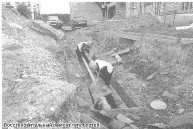
Восстановительный ремонт теплосетей
