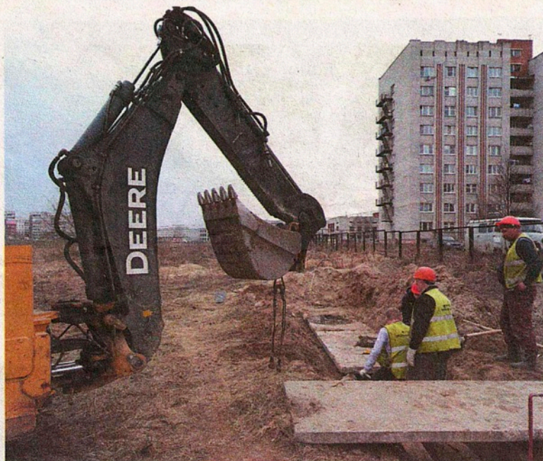
Аварийно-строительные бригады оснащены современной техникой.
