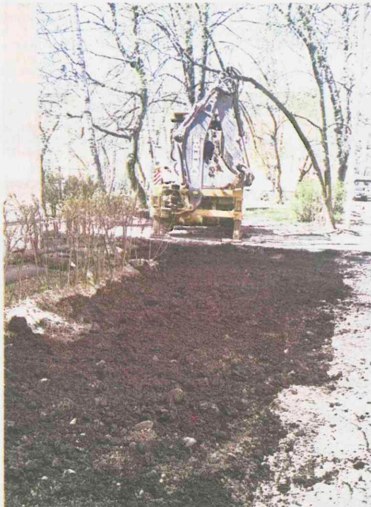
Восстановительные работы по благоустройству
